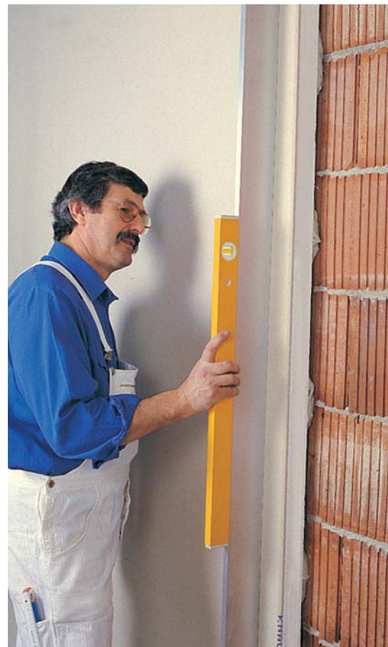
Приклеивание гипсокартонной плиты с помощью гипсового клея Кнауф-Перлфикс, нанесенного мастерком.
