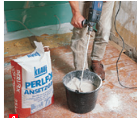
2 Возьмите упаковку "КНАУФ ПЕРЛФИКС", высыпьте ее в воду и с помощью электродрели с насадкой-мешалкой замесите до пастообразной массы.
