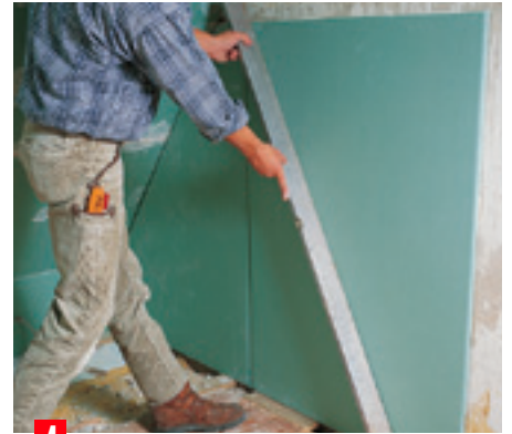
4 Лист приложите к стене, придавите и проверьте рейкой-правилом, расположена ли ее поверхность в одну линию с другими плитами.
