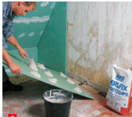
3 Крупными комками клей нанесите на тыльную сторону заранее подготовленных листов. Расстояние между каждым комком ~ 30 см.
