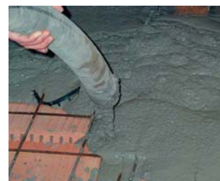
Заливка бетоном
