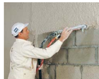
Внутренние штукатурные работы
