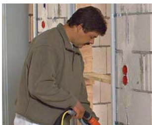
Заделка дверных коробок раствором
