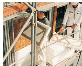
Нанесение клеящего раствора
