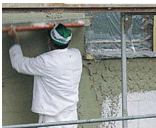
Наружные штукатурные работы
