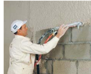
Внутренние штукатурные работы
