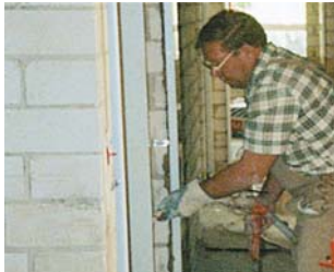
Заделка дверных коробок раствором
