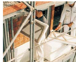
Нанесение клеявого раствора
