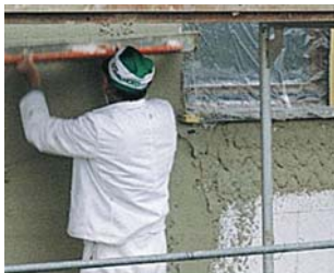
Наружные штукатурные работы
